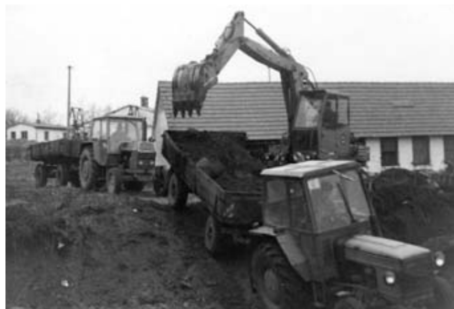
Stavba hokejového hřiště pod Nezdřevem, 1979
