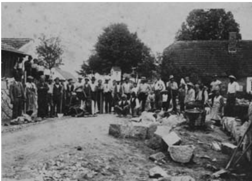
Stavba silnice v obci mezi čp. 11 a čp. 23, 1933
