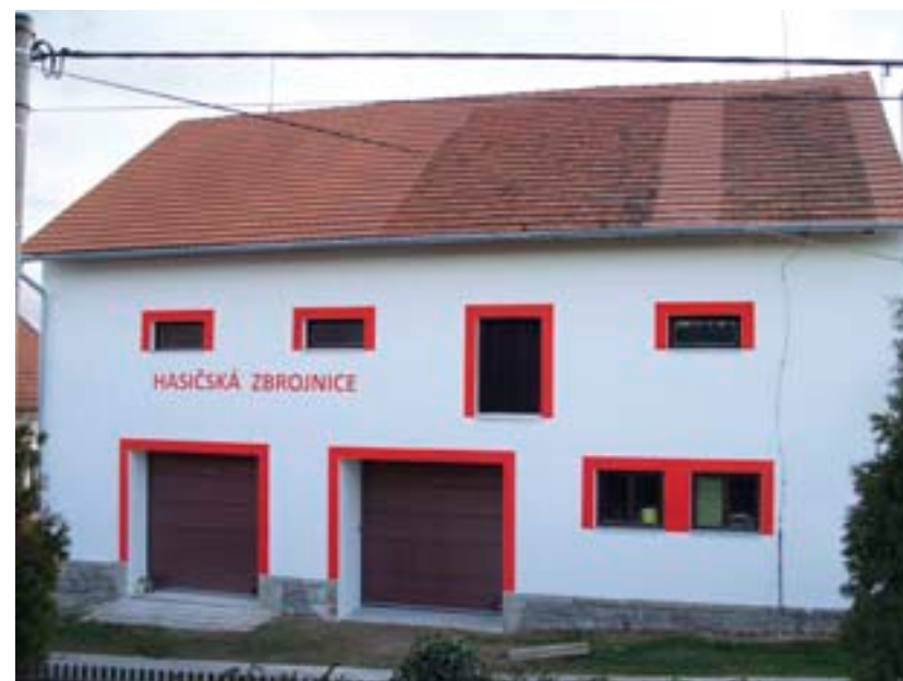
Hasičská zbrojnice po rekonstrukci, 2010
