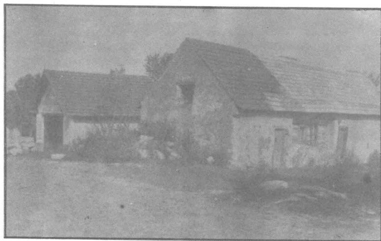
PŮVODNÍ HASIČSKÁ ZBROJNICE
